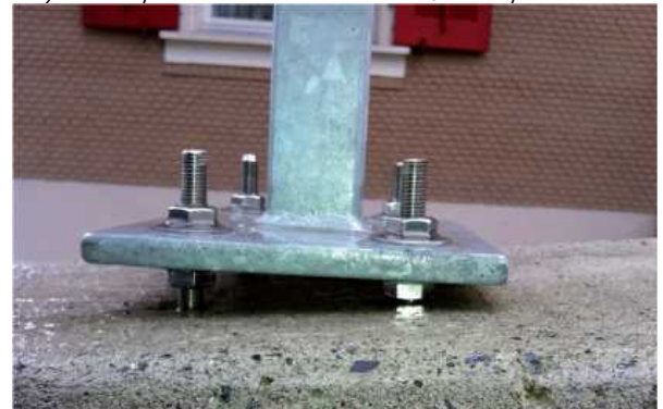
Рисунок 4: Крепление колонны с помощью опорной ножки
